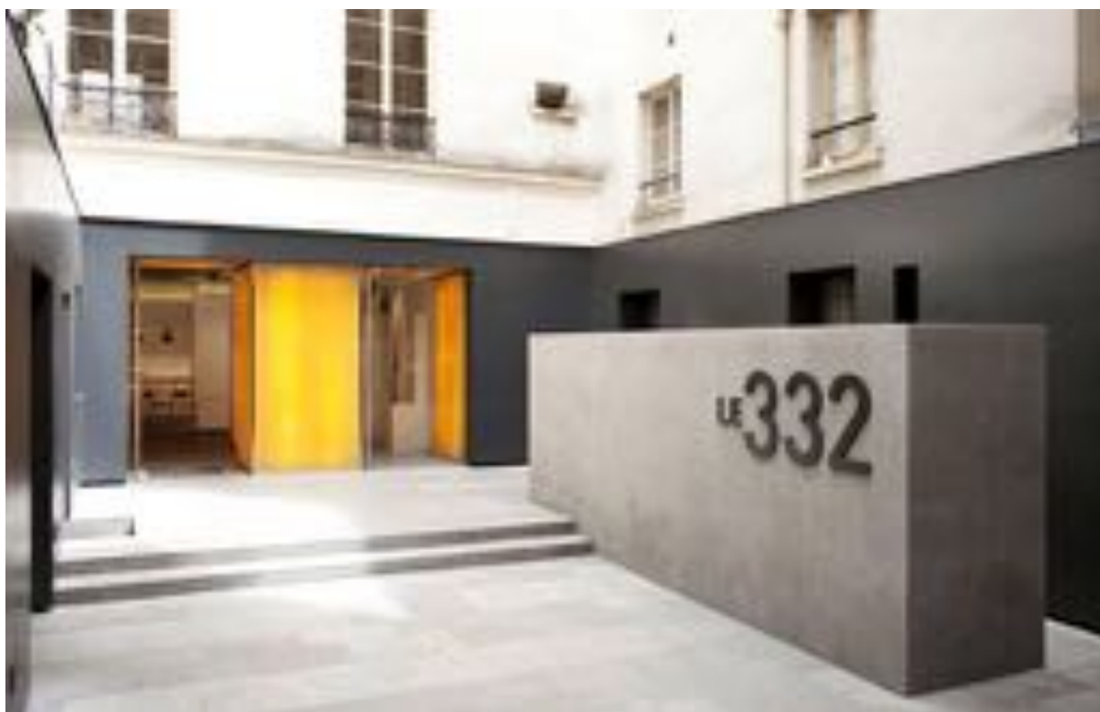
La cour et le sas lumineux d'entrée du show room – Mur écran signalétique
