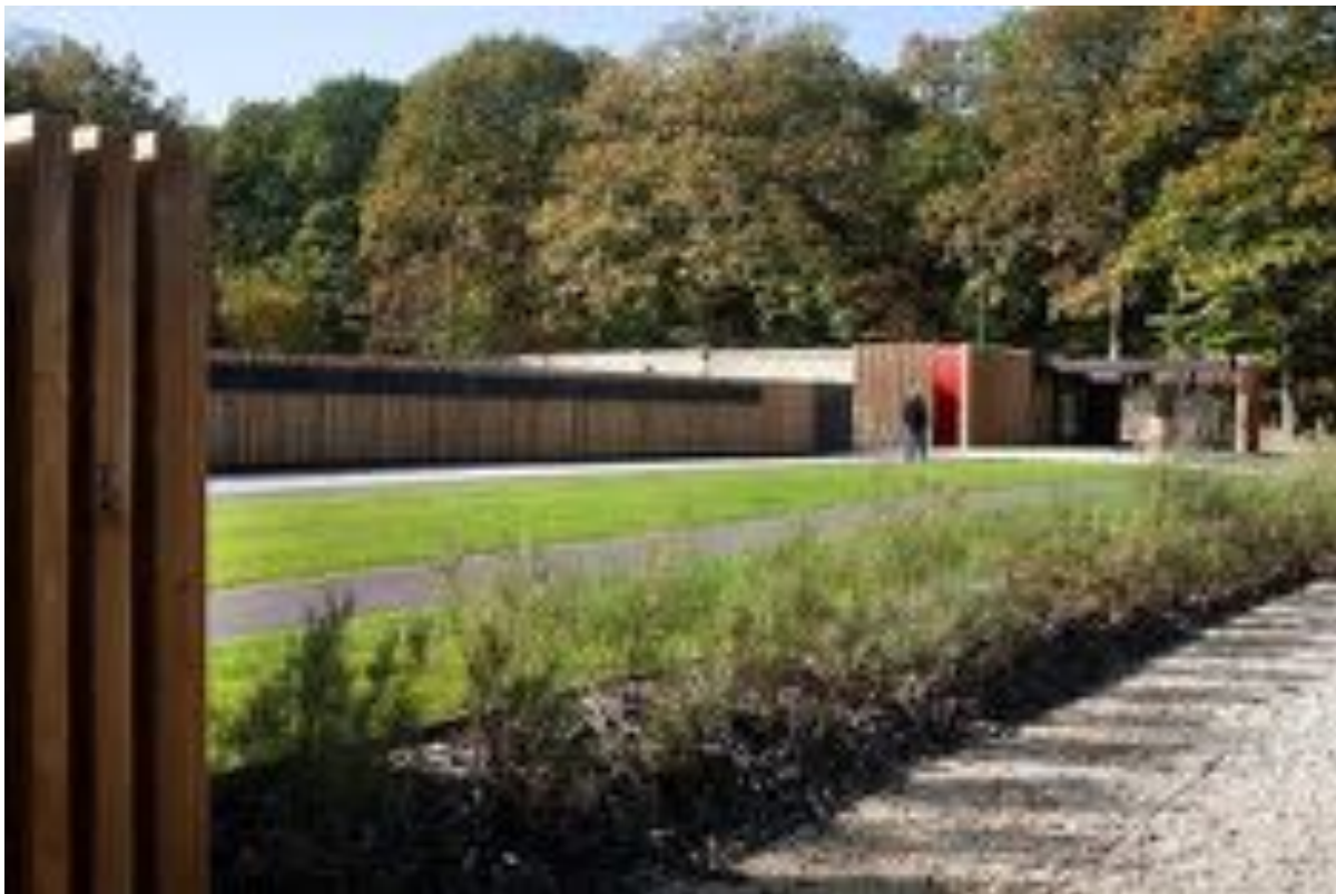
Vue du site montrant le mur des columbariums et le bâtiment d'accueil
